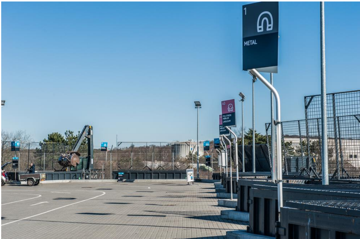
Figur 5: Den eksisterende genbrugsplads (Halsnæs Forsyning).
